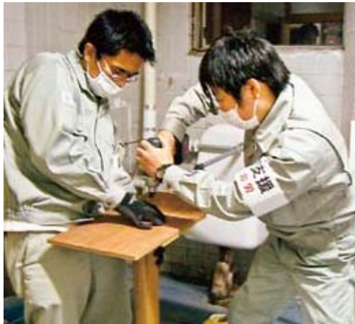
洗濯機置き場の水回り作業をする札幌市労の上野(左)さんと二本柳さん(右) = 4月21日、宮古小学校
