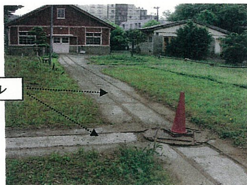
▲トロッコレール敷設状況(正面建物は農場博物館)
