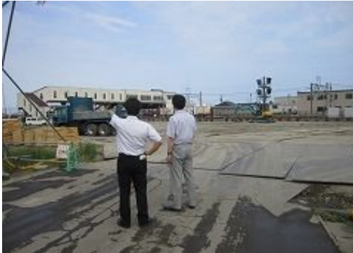
新幹線駅舎建設現場（木古内）
