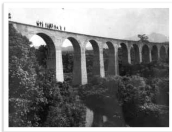
越川橋梁(1973年以前の撮影) 中央部は現在ない。
