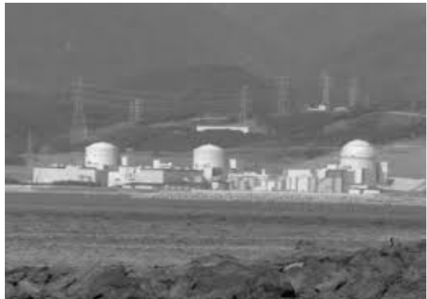
(泊原子力発電所 遠景)
