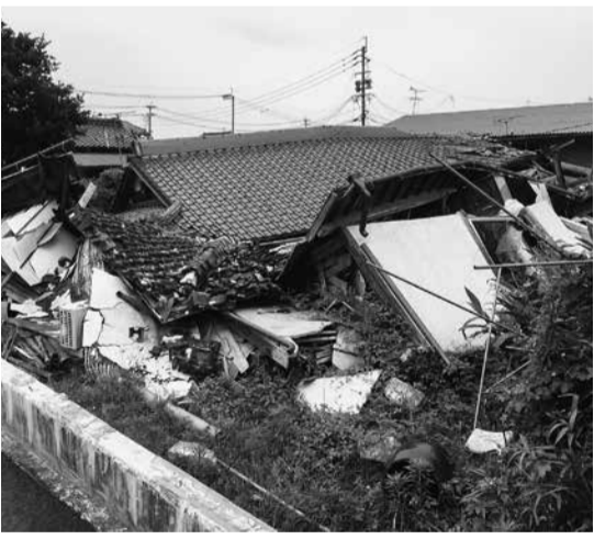
そのままの状態に残っている倒壊した家屋=益城町
