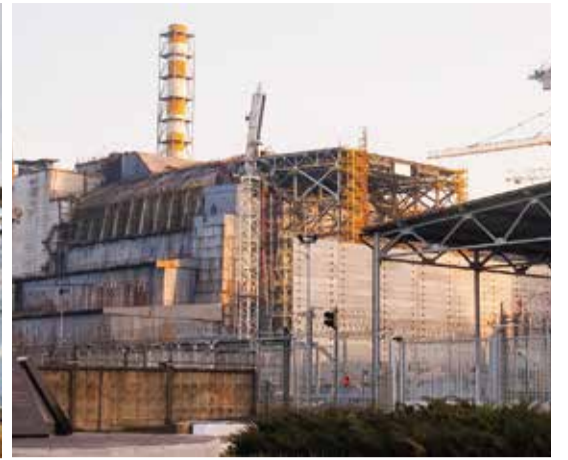
チェルノブイリ原発4号機。現在は「石棺」と呼ばれるコンクリート製シェルターで覆われているが、老朽化がめだつ=2015年1月
