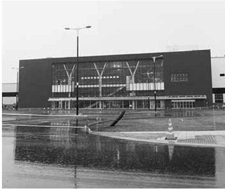
建設中の新函館北斗駅
