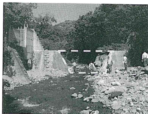
写真5 良留石川スリットダム 点線枠が切欠いた箇所
