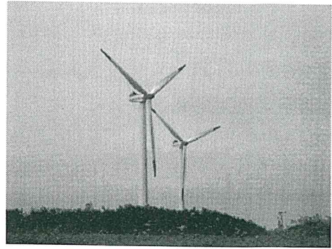
【井の三風力発電所】
