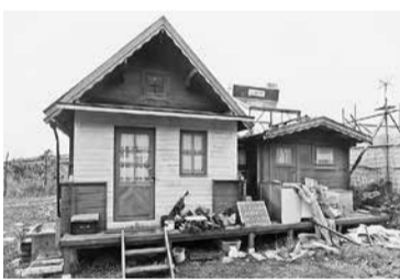
大間原発建設地内に建つ『あさこはうす』
