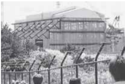
建設を中断している大間原発建屋
